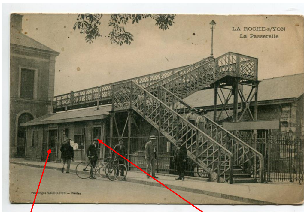
L'entrepôt postal était déjà construit
