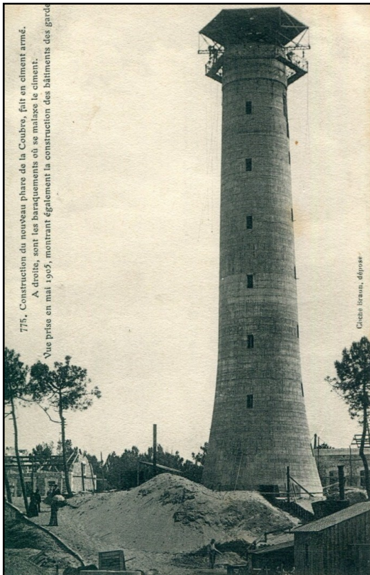
Construction du nouveau phare de la Coubre en ciment armé (vue prise en 1905) Cliché Braun
